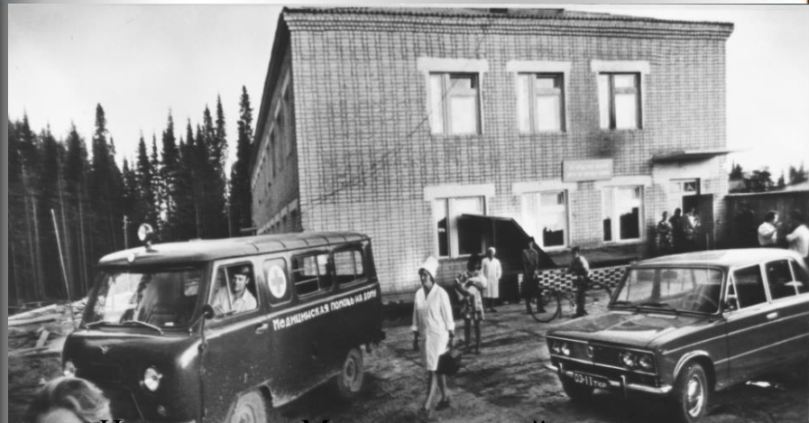
Новое здание Междуреченской поликлиники. Общий вид.
