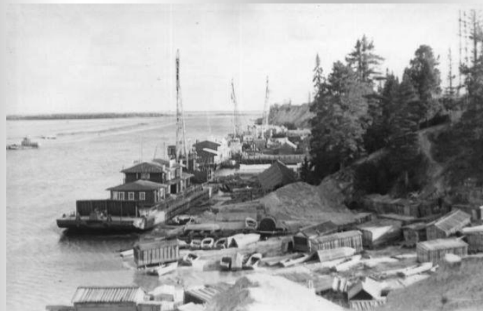
Причал д.Устье - Аха
