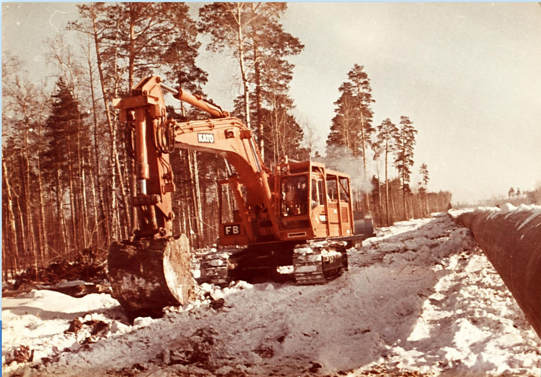
Экскаватор КАТО во время подготовки шурфа для укладки трубопровода нитки Холмогоры-Клин. п. Леуши. 1981 год. Ф.109. Оп.2. Д.149. Л.1
