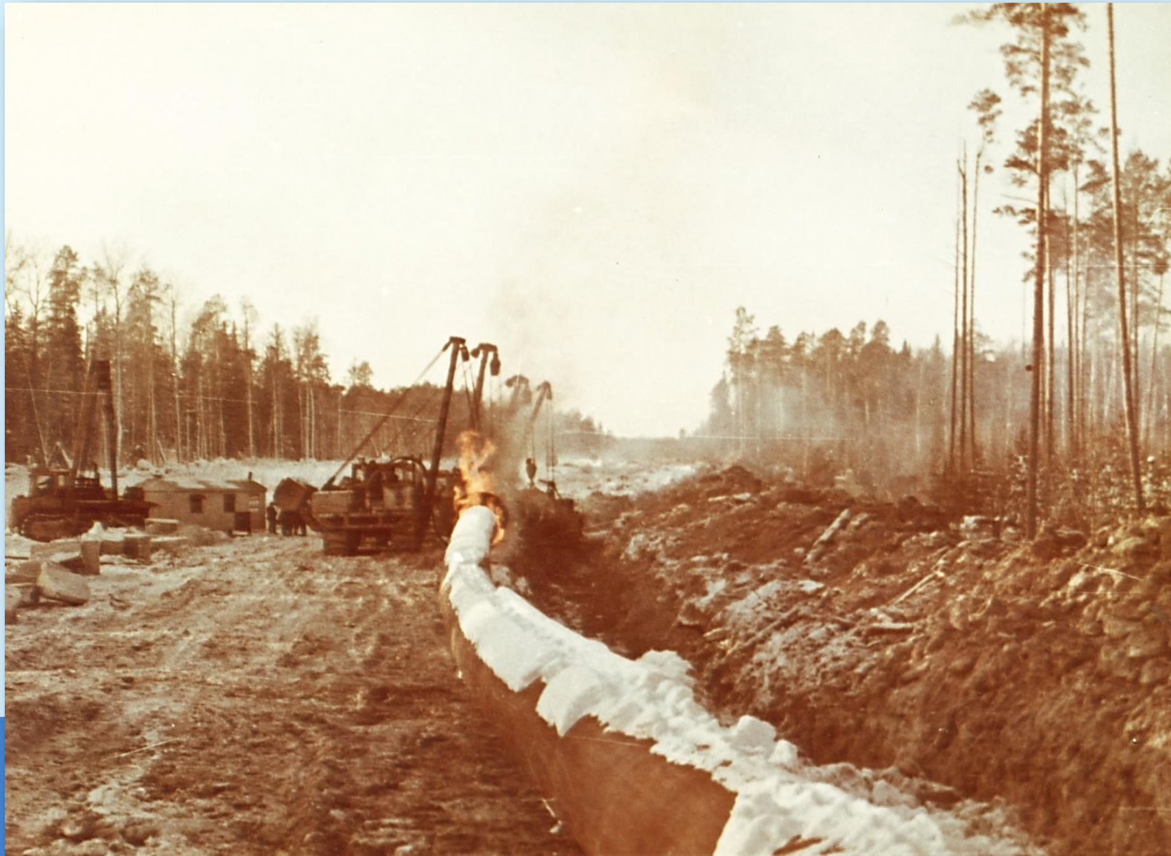
Автомашины - трубоукладчики на нитке нефтепровода Холмогоры - Клин п. Леуши. 1981 год Ф.109. Оп.2. Д.150. Л.1
