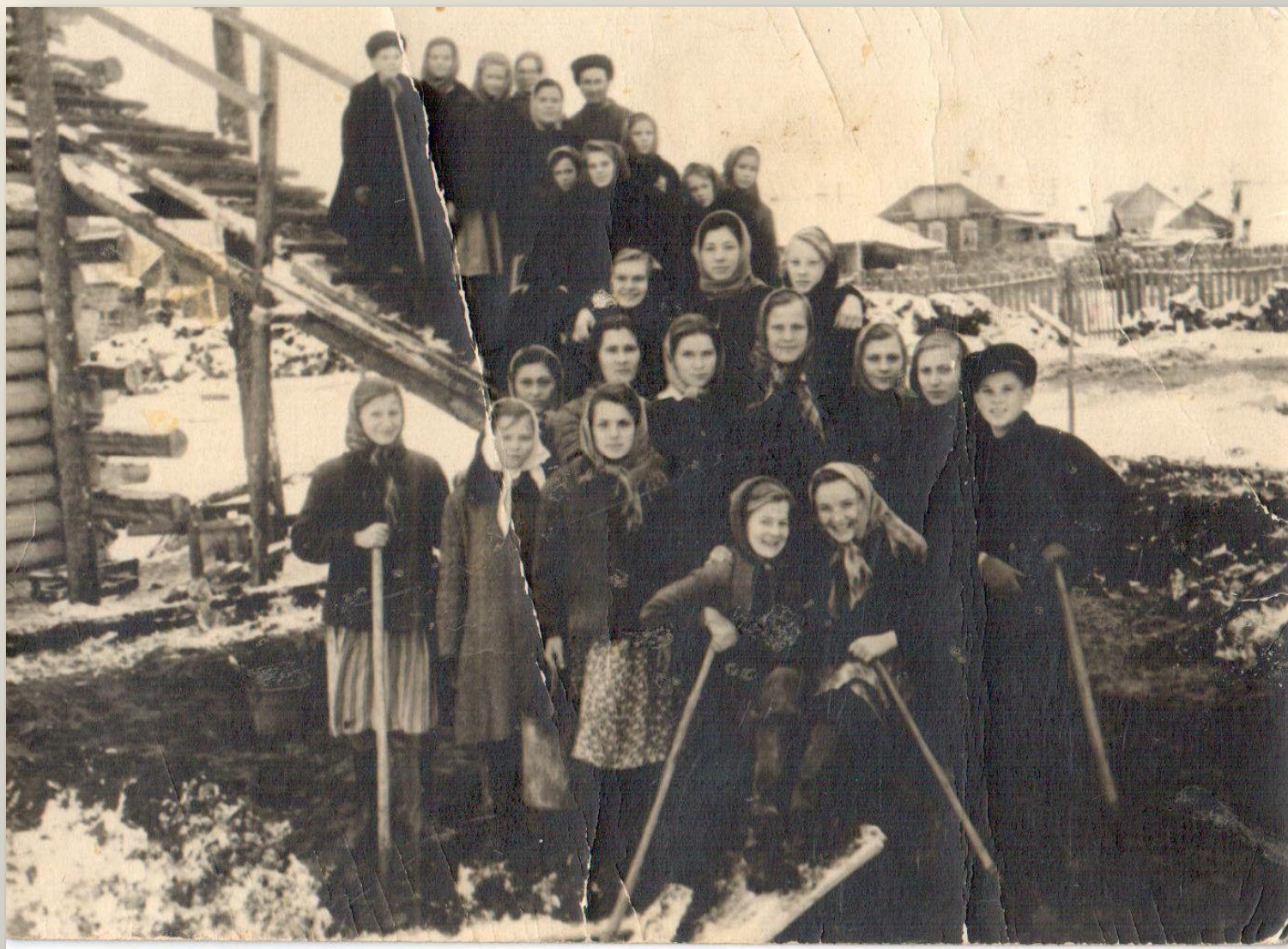
Учащиеся Кондинской средней школы на строительстве первого спортивного зала в Кондинском районе. Начало 1960-х.
