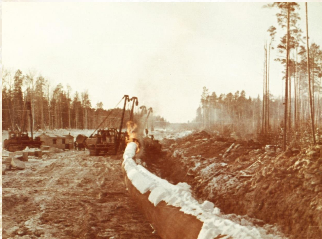
Автомашины-трубоукладчики на нитке нефтепровода Холмогоры-Клин, 1981 г.
