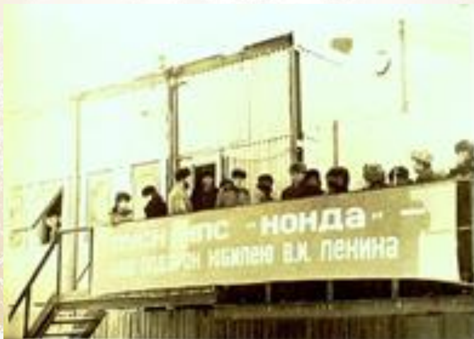
Пуск нефтеперекачивающей станции (НПС) «Конда».
