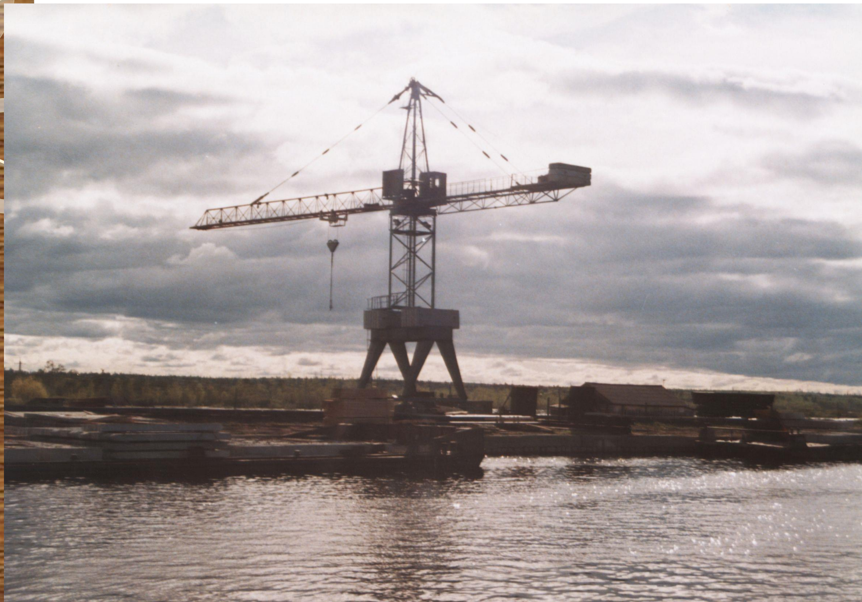
Башенный кран КБ-10 на причале Вода-Вагон, место перегрузки плотов на железнодорожные вагоны. 2002 г. Ф.109. Оп.2. Д.339. Л.1
