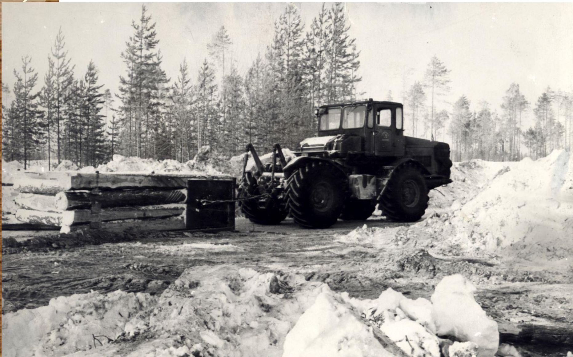
Подготовка зимних лесовозных дорог трактором КА-700 Междуреченский ЛЗУ п. Междуреченский. 1960 г. Ф.109. Оп.2.Д.60. Л.1
