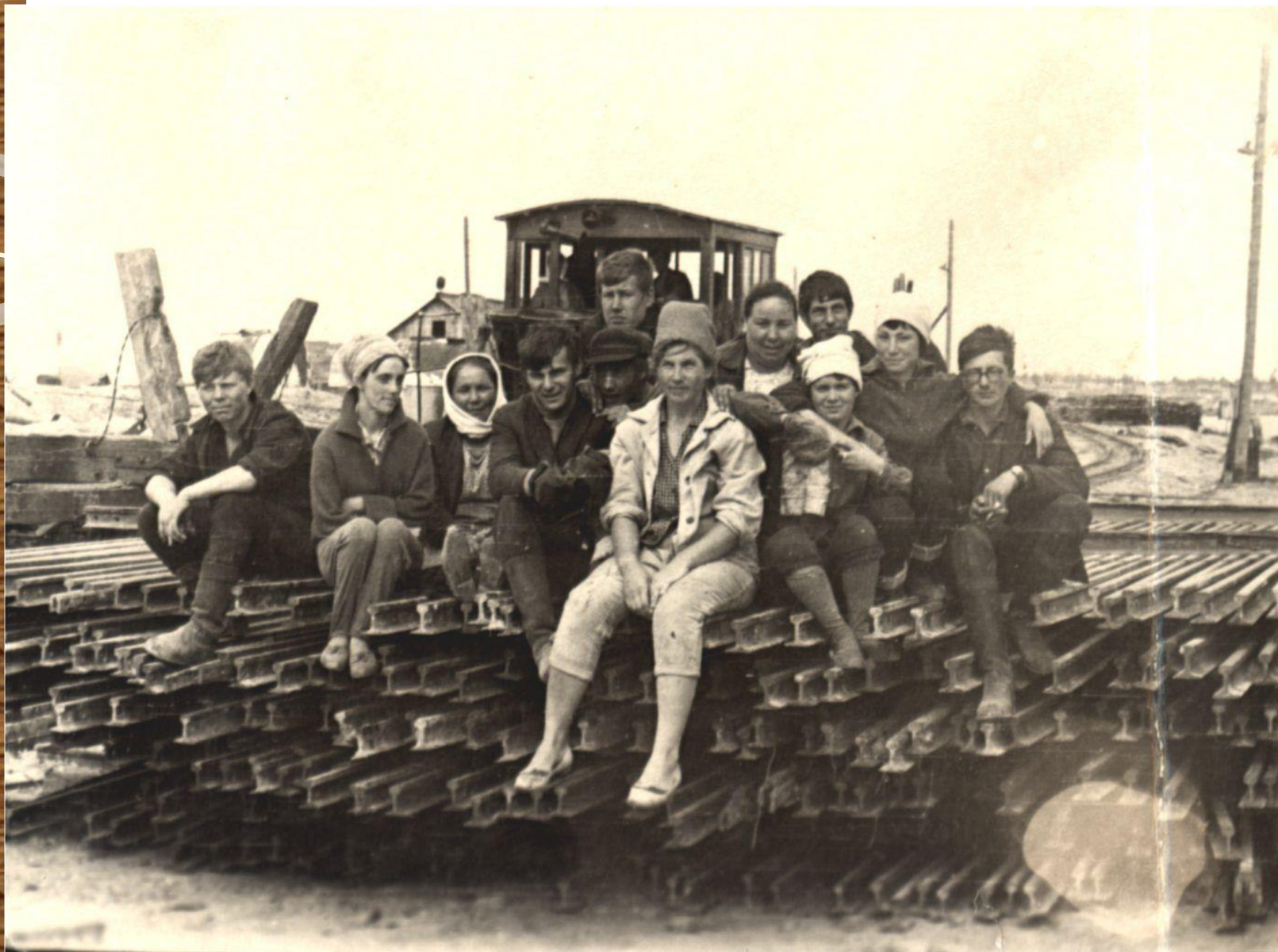
Бригада работников Луговского лесопункта на разборке рельсов узкоколейной железной дороги. 1968 год Ф.109. Оп.2. Д.1591. Л.1
