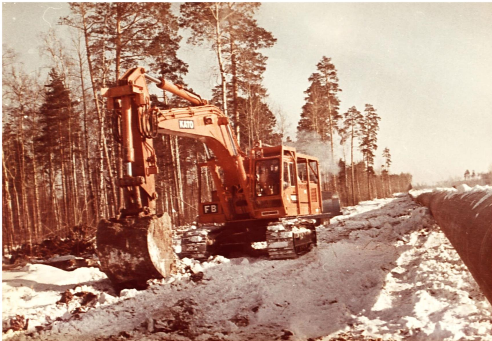
ЭкскаваторКАТО во время подготовки шурфа для укладки трубопровода нитки Холмогоры-Клин. п. Леуши. 1981 год.
