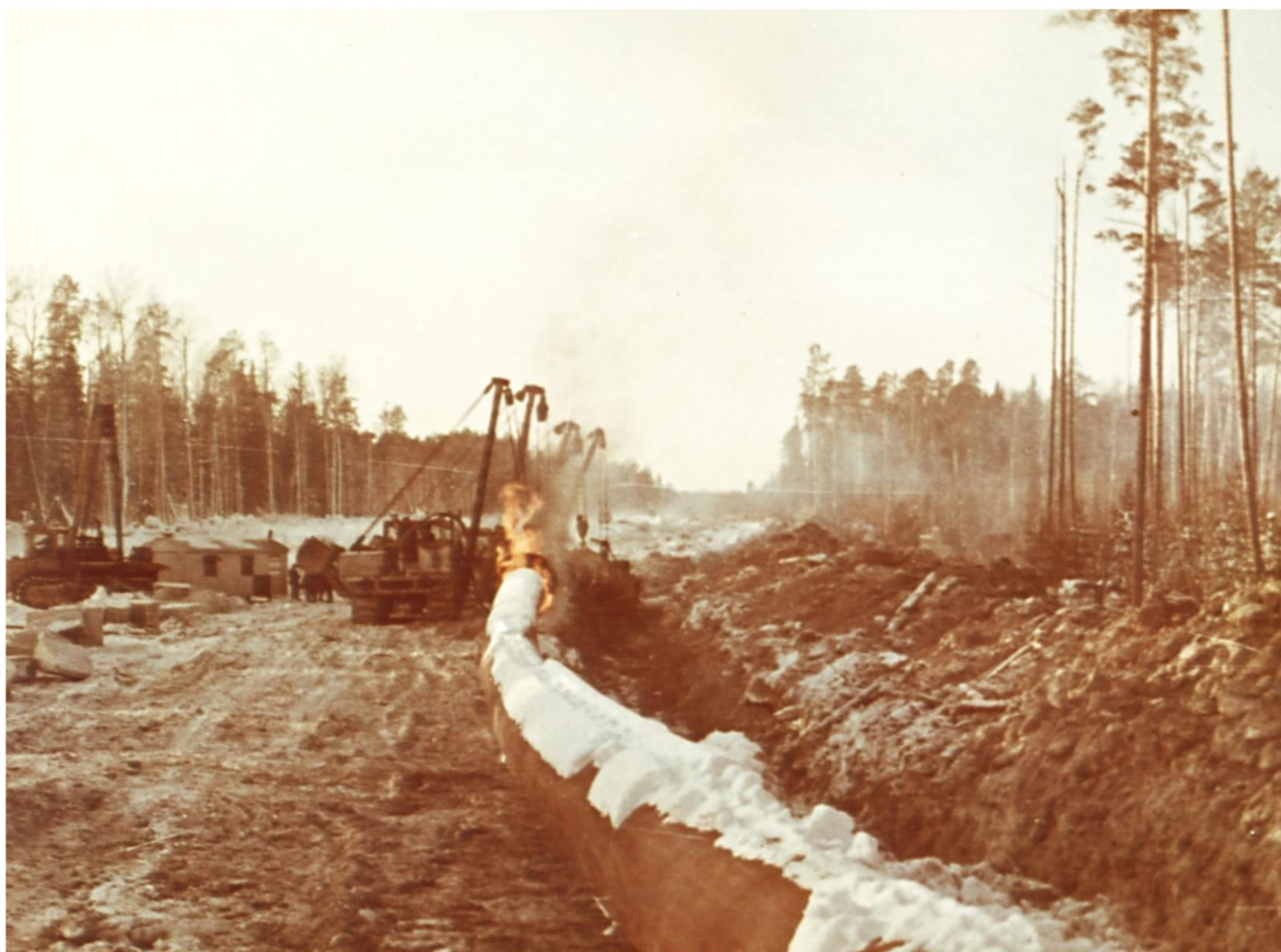
Автомашины-трубоукладчики на нитке нефтепровода Холмогоры-Клин п. Леуши. 1981 г.
