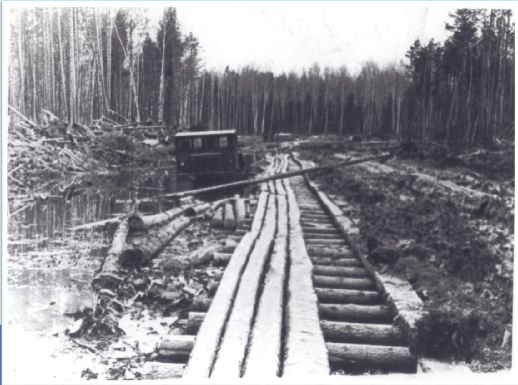
Первая лежневая дорога на головные сооружения НПС «Шаим». Начало нефтепровода «Шаим-Тюмень». 1965 год
